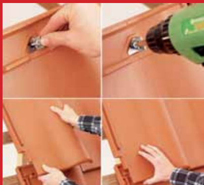
Sicher, verwechslungsfrei und leicht zu montieren: Die systemeigene integrierte Sturmfix-Klammer hat ihren festen Platz im Dachziegel.
