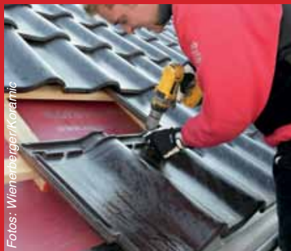
Sicher, verwechslungsfrei und leicht zu montieren: Die systemeigene integrierte Sturmfix-Klammer hat ihren festen Platz im Dachziegel.
