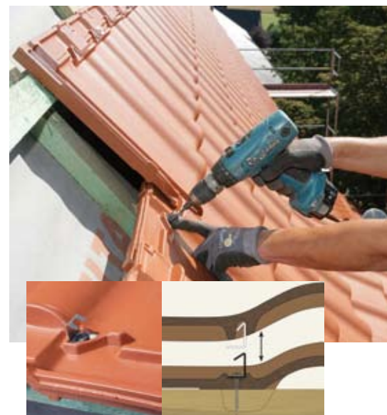
Sturmfix: Ziegel und Klammer verschmelzen zu einer Einheit.
