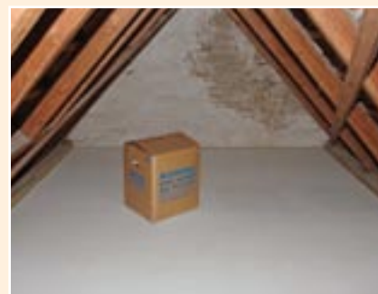
Fertig: glatt, stabil und belastbar
