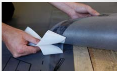
Nahtsicherung mit Doppelklebestreifen: Permo® SK 2
