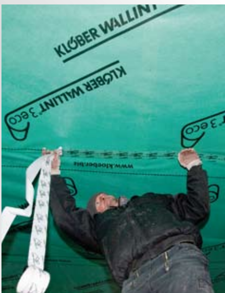
Die luftdichte Verklebung der Klöber Luftsperr erfolgt im System mit dem Klebeband Permo® TR.
