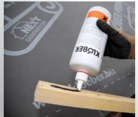
Perforationssicherung mit Konterlattendichtmasse Permo® seal
